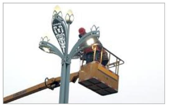
11月25日，路灯所人员维修汝河桥中华灯故障路灯光源。 梁杨子 摄
