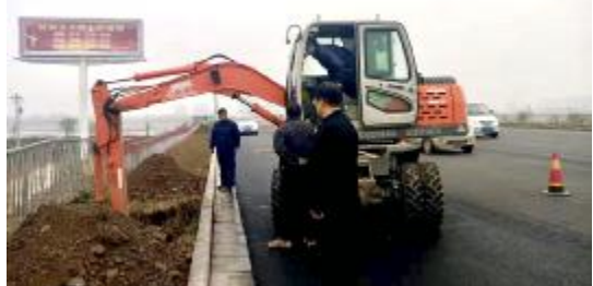
11月26日，望嵩南路工人正在进行路灯基础开挖。 陈晶 摄
