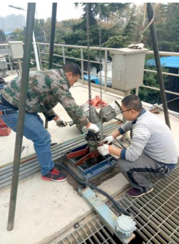
随着温度逐渐降低,为确保污水稳定达标排放,近日,城东污水处理厂根据今年冬季设备检修计划的安排,在不影响运营的情况下,再次对全厂设备进行检修保养。
