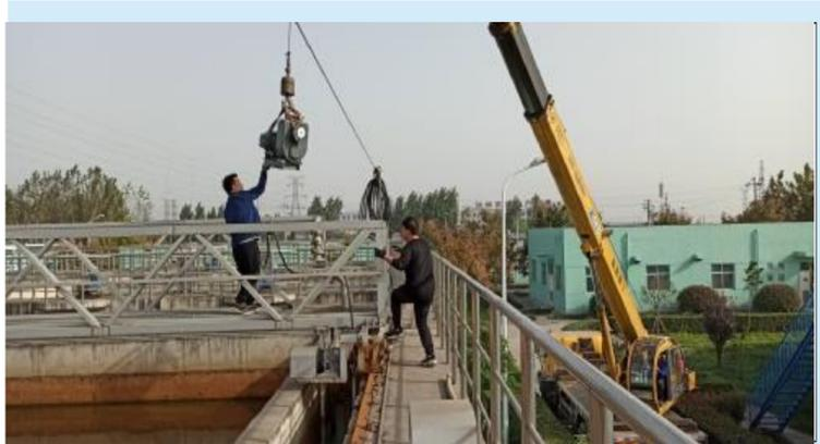
日前，产业集聚区污水处理厂组织机修工人利用大型起重设备对厂区重型设备进行起吊抢修。由于污水处理设备24小时不间断运转，运行环境恶劣，维修及保养工作尤为关键，及时抢修设备可确保污水处理厂安全稳定运行，为改善区域生态环境、促进经济发展奠定基础。
