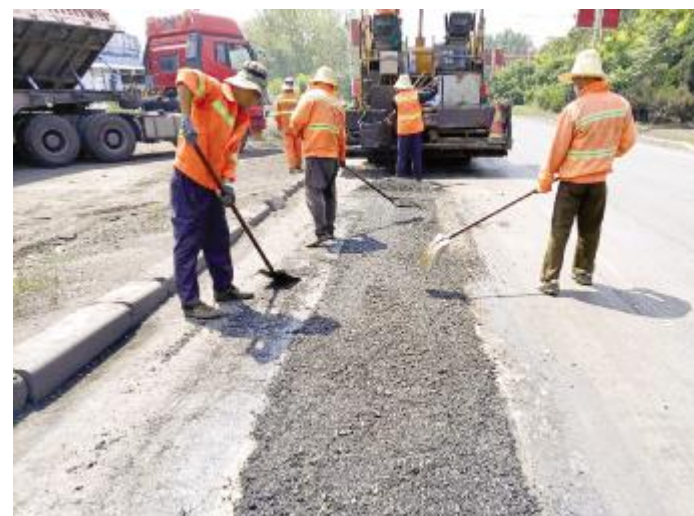
挖补坑槽,处理道路“病害”
