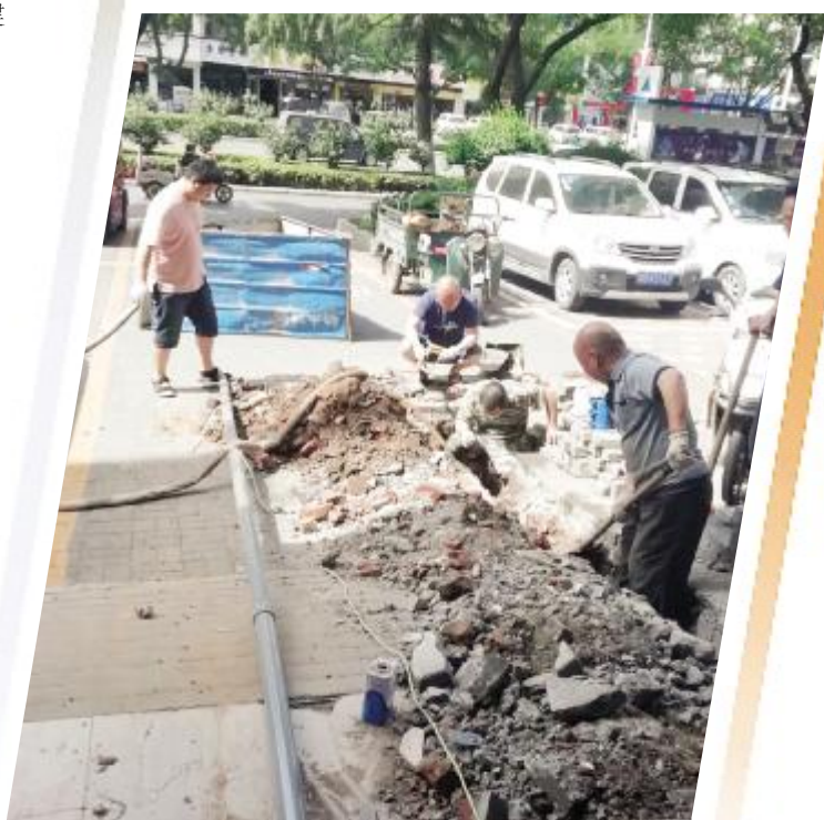
市政工人抢修供水管道
