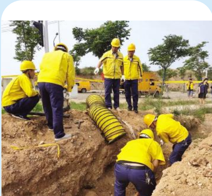
新奥燃气有限公司开展燃气管网泄漏应急演练
