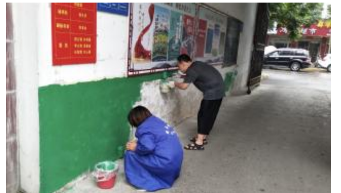
7月21日，市委宣传部组织工人对结对共建的利民小区美化改造。图为工人对过道墙体修补、喷漆。梁杨子 刘亚飞 摄
