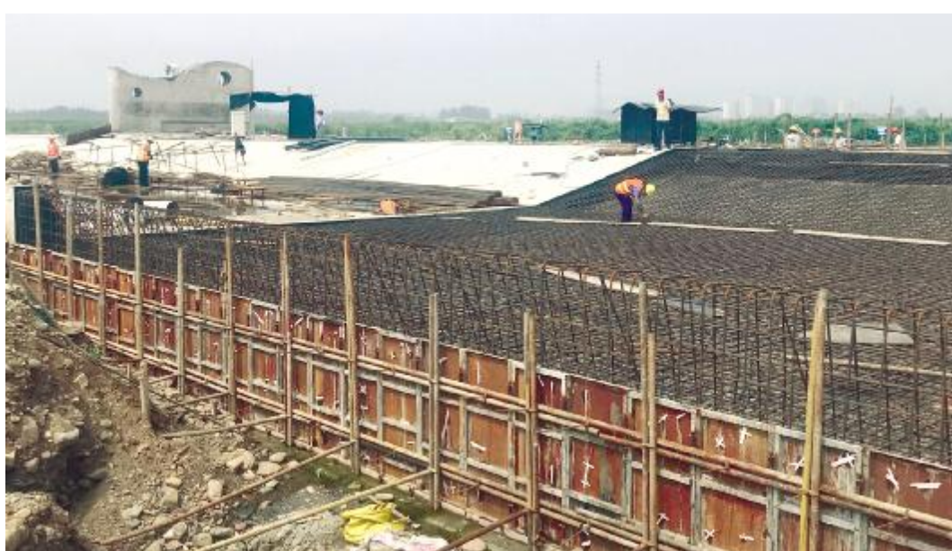
7月15日,在北汝河5号橡胶坝施工工地,施工车辆有序开展作业,工人们正在橡胶坝二号消力池施工。据现场项目负责人张乐吉介绍,北汝河橡胶坝作为重点民生工程,目前已完成工程量的90%,预计今年年底完工,完工后可提高青年渠的供水保证率、形成城区段梯级连续水面,为市民提供休闲娱乐健身的理想场所。
