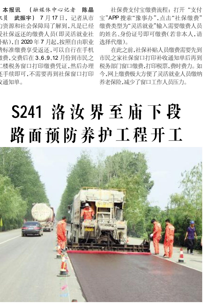
施工人员在S241庙下镇唐店段进行微表处摊铺
