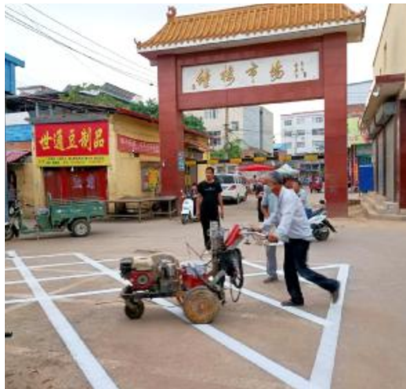
近日，钟楼市场组织工作人员规划新的道路导流线和停车位，避免周边交通在早晚高峰拥堵以及车辆长时间占用的问题。
