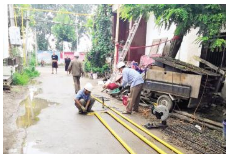
铺设天然气管道
