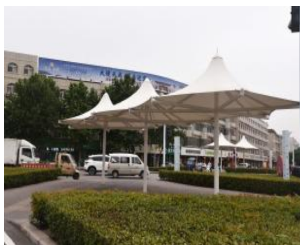
各个路口建设的遮阳棚
