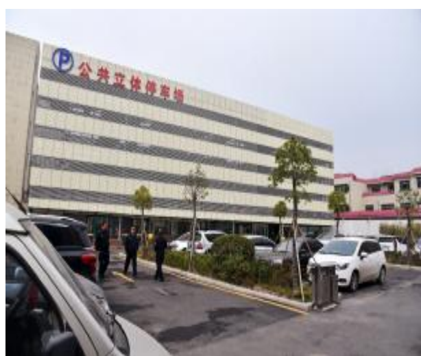
朝阳路与风穴路交叉口的公共立体停车场
