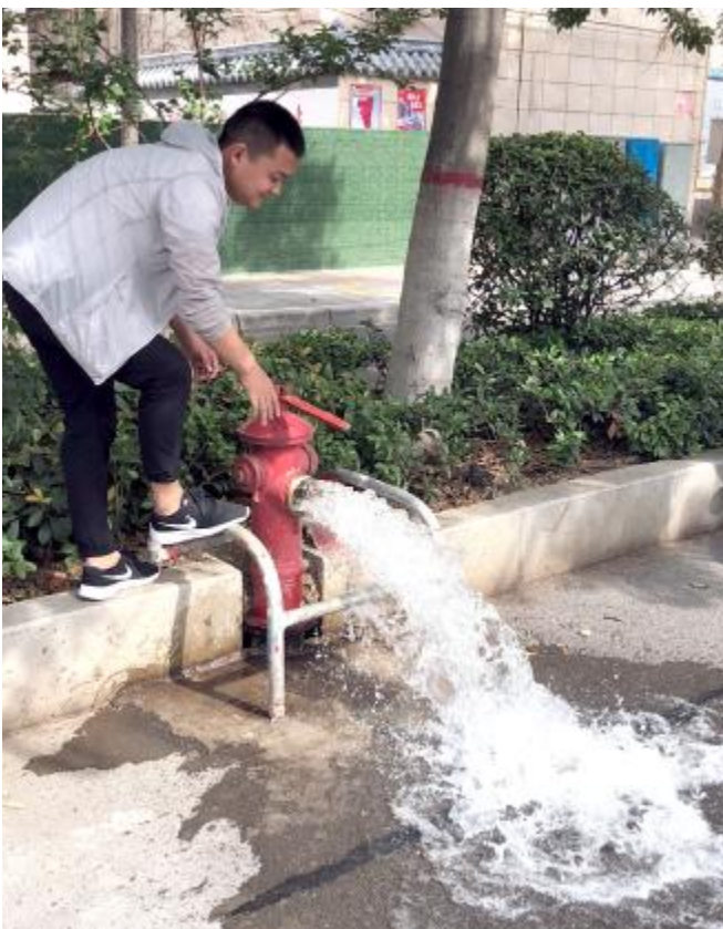
5月25日，市自来水公司对城区100多个消防栓进行检查，确保消防栓正常使用，保证抗旱苗圃用水。 梁杨子 赵珊 摄
