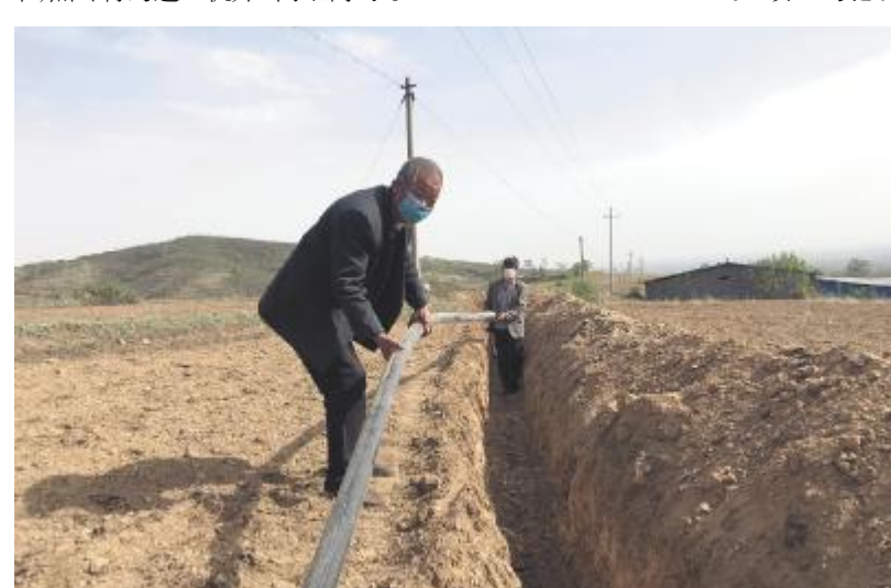
焦岭村村民正在铺设地理管道
