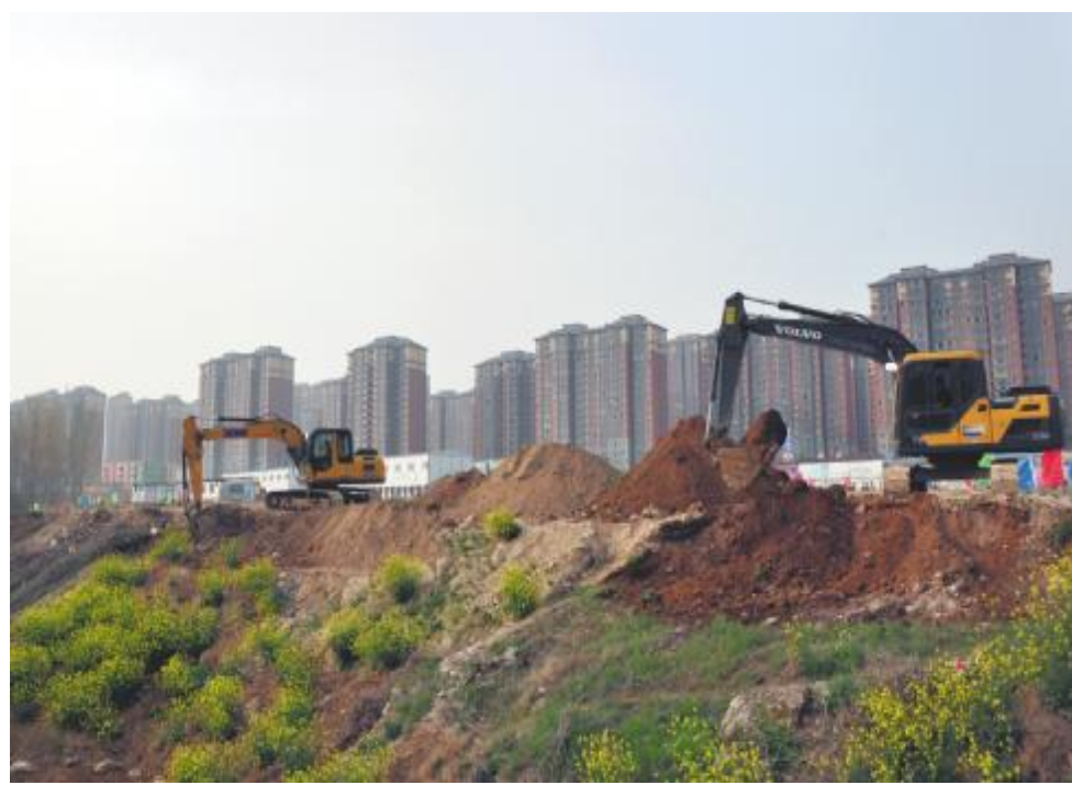
3月31日，温泉镇牛洞河旁一片施工繁忙景象。据项目负责人介绍，牛洞河风情带是温泉镇生态大动脉，项目位于温泉镇中部，横贯温泉镇区，全长4500米，占地面积1800余亩，分河道水工程和景观两部分工程，总投资约3.8亿元。项目概念性规划及初步方案由深圳市北林苑景观及规划设计院有限公司设计完成，由棕榈生态城镇发展股份有限公司建设。
