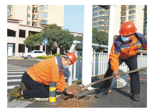
连日来,市路灯所在做好单位疫情防控工作的同时,集中力量开展全市照明亮化设施春季 安全隐患排查和检修工作。检查过程中技术人员通过"看、测、效"等方式,对市区范围内照明设 施(变压器、配电箱、灯杆、线路等)进行零漏项、全覆盖精细化管护和检测。截至目前,共处理变 压器、线路等故障 28 台次,调校配电箱 16 台次,更换老化高压设施 3 套,维修路灯控制柜电器 元件6台。 宋乐义 齐彩燕 摄
