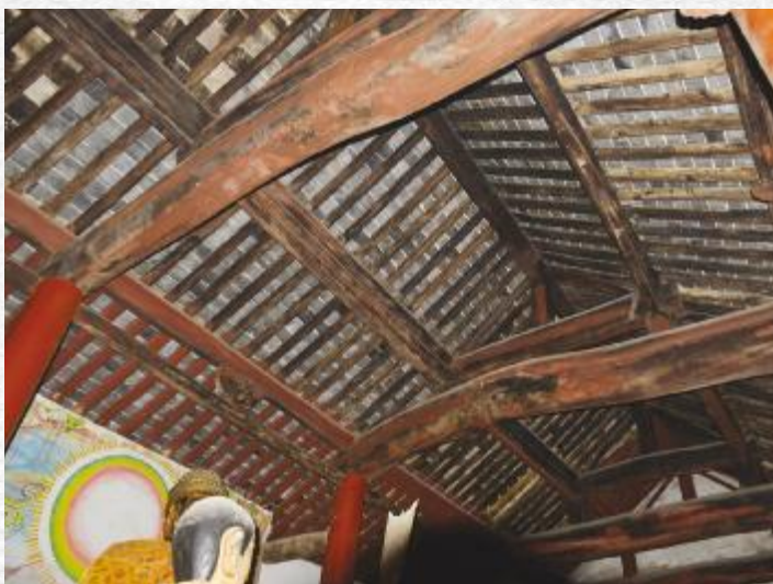
大雄宝殿殿内木梁结构完整
