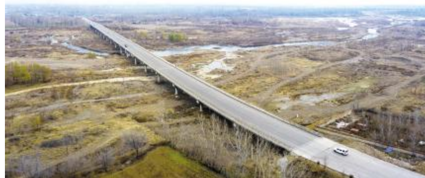
通车后的小北线汝河大桥
