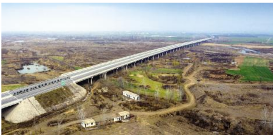
汝登高速汝河特大桥
