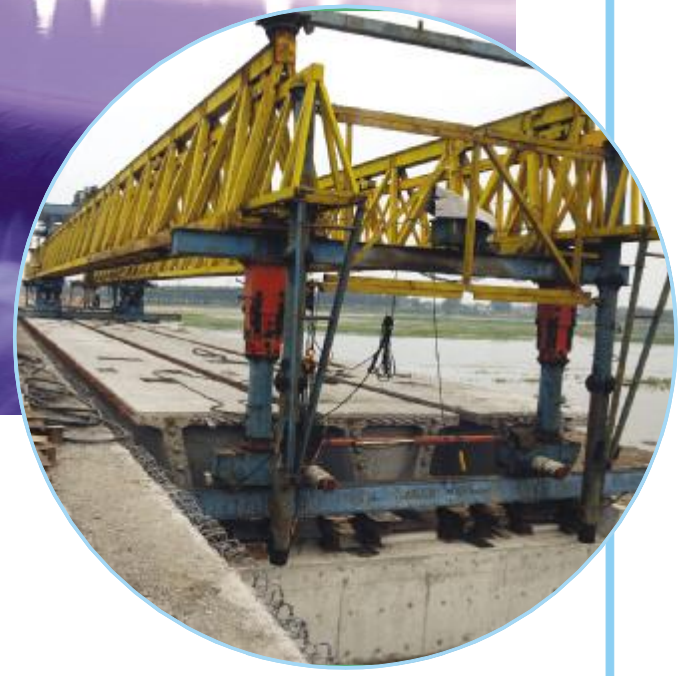
加宽施工中的望嵩路汝河大桥
