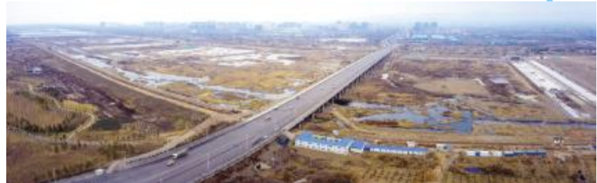
通车后的新G207汝河大桥
