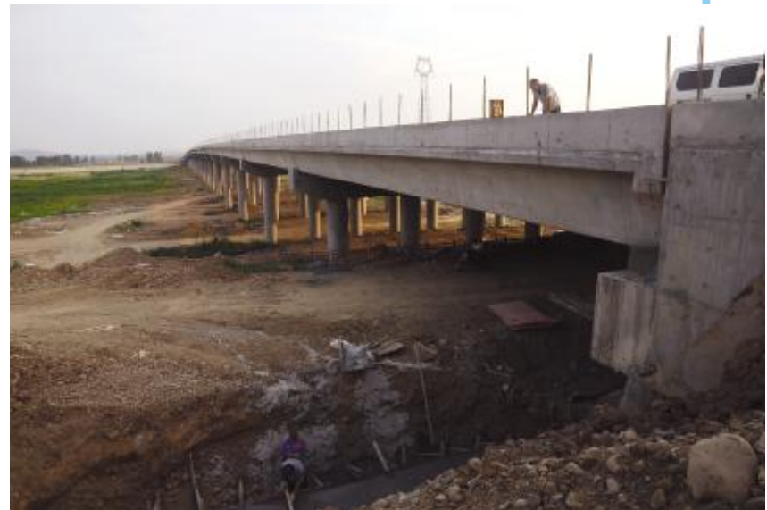
建设中的新G207汝河大桥
