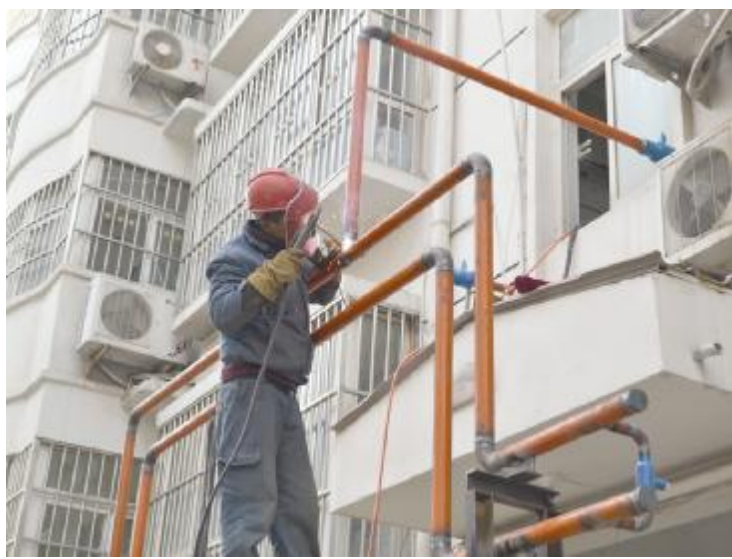
工人在利民小区焊接集中供暖二次管网
