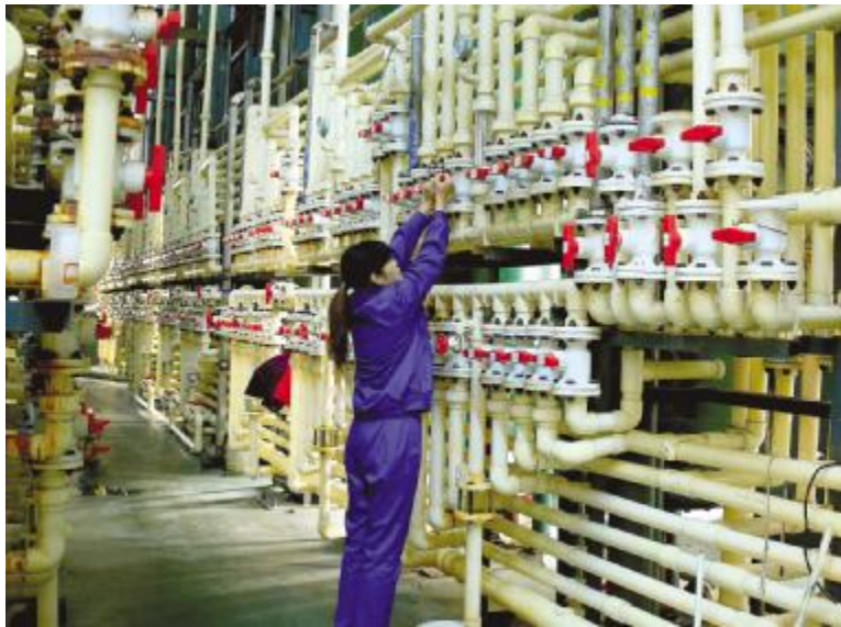
仁华生物工作人员正在检修设备
