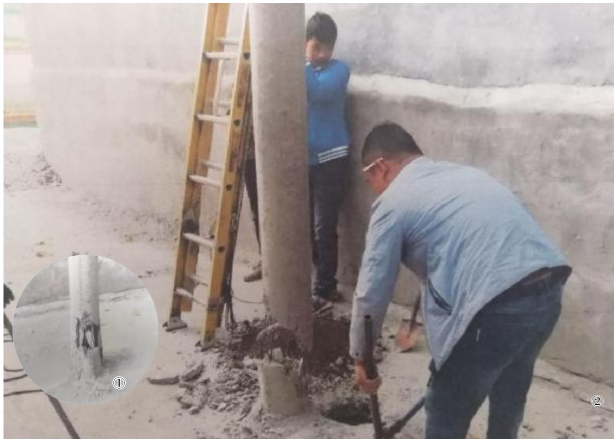
图①为原本破损电线杆；图②为施工人员在修补电线杆
