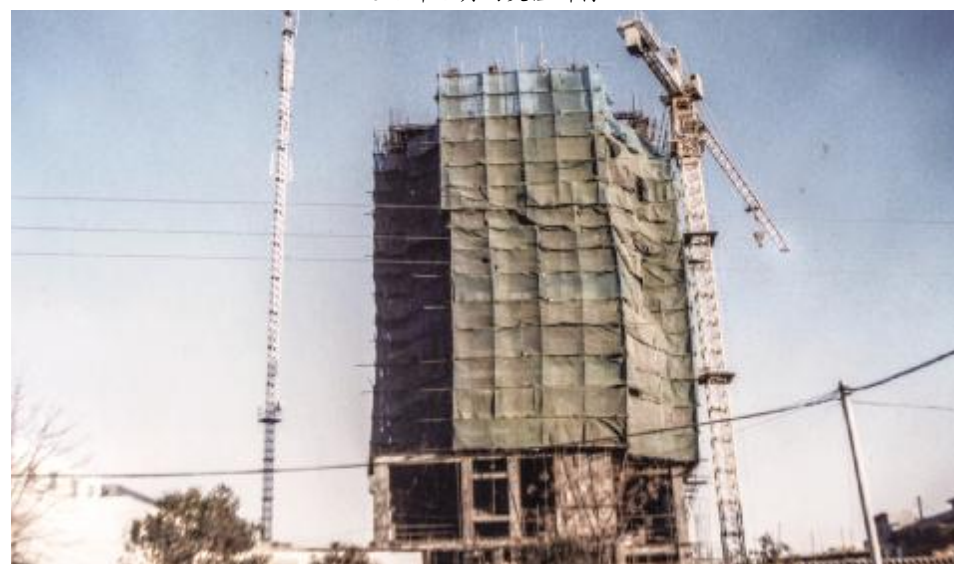
1999年施工中的广电大厦
