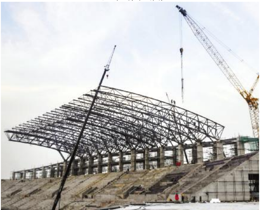
2016年11月建设中的体育中心足球场
