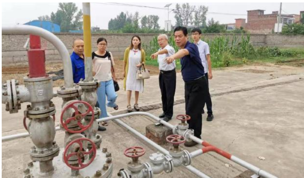
8月27日，市住建局邀请相关专家检查我市燃气安全工作，并提出具体指导意见。图为检查组在立交桥西锦星燃气供应站处检查。
