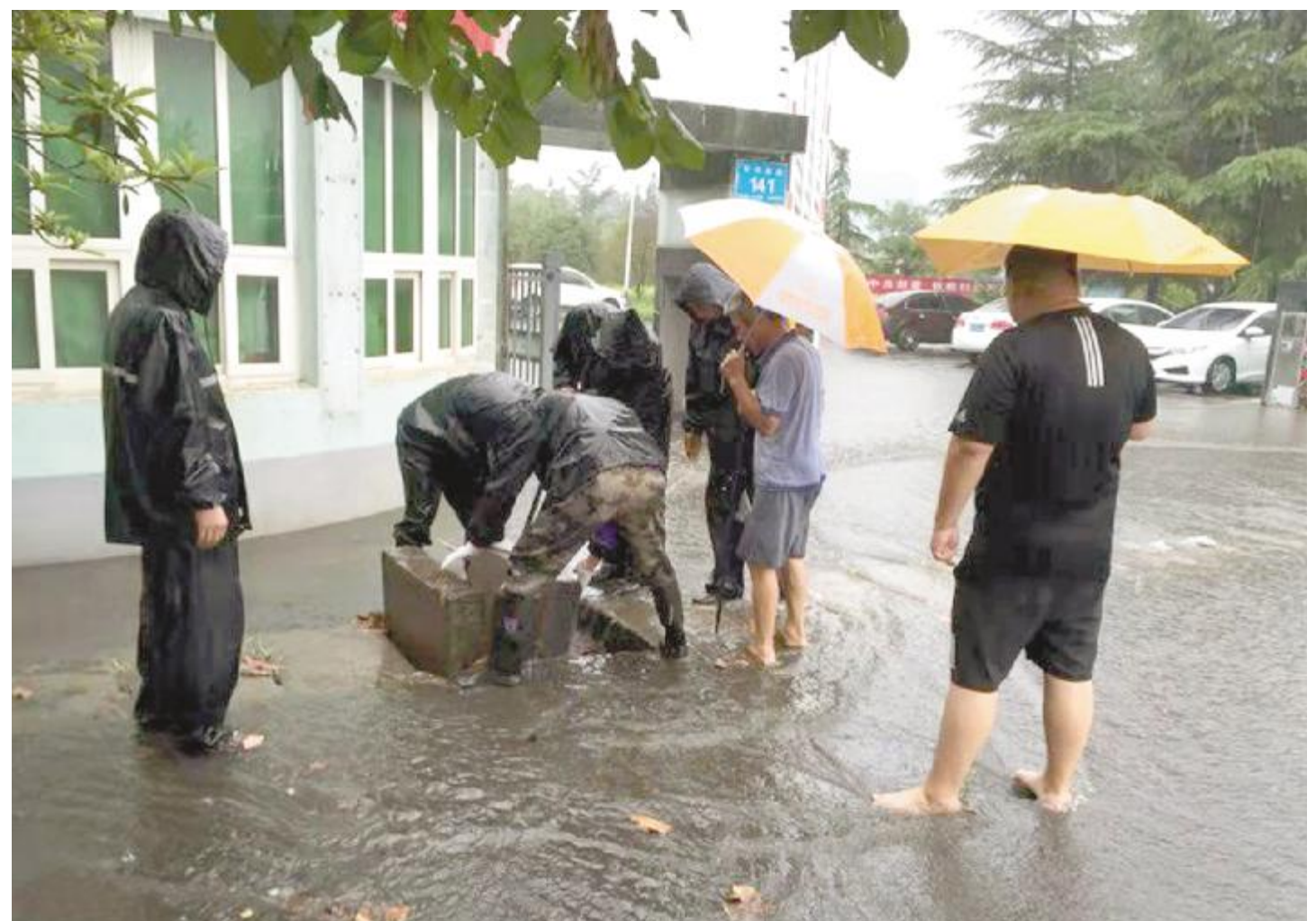
市政工人在宏翔大道城东污水处理厂门口疏通管道
