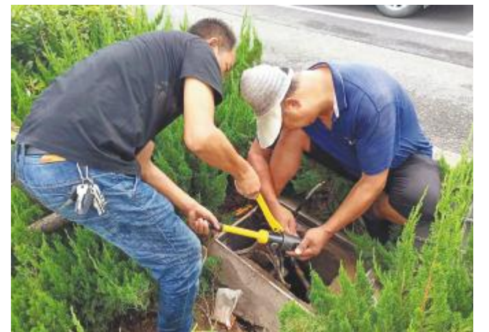
工人雨后维修线路
