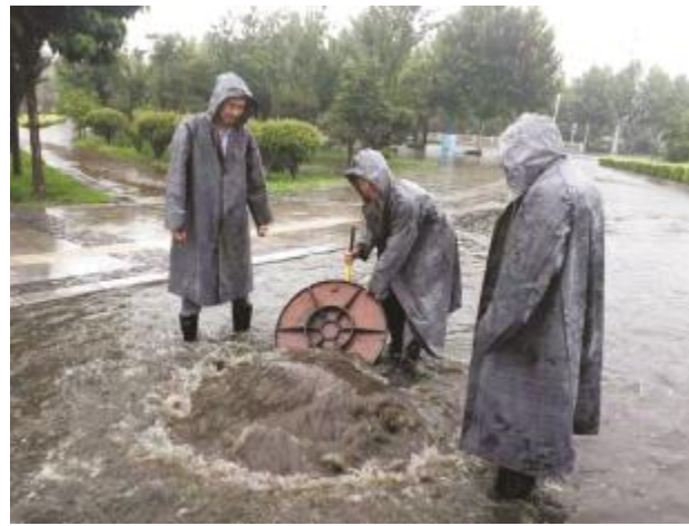
市政工人在宏翔大道与建设路交叉口疏通下水道
