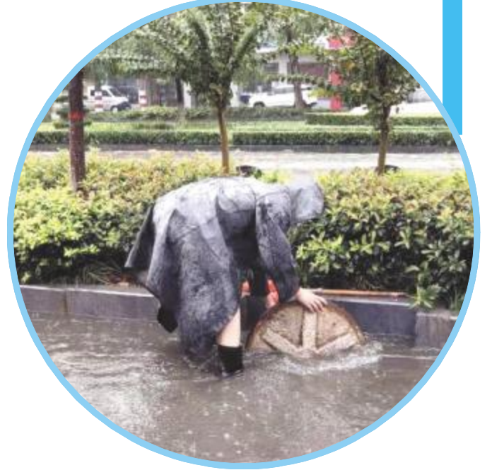
市政工人在丹阳东路疏通下水道
