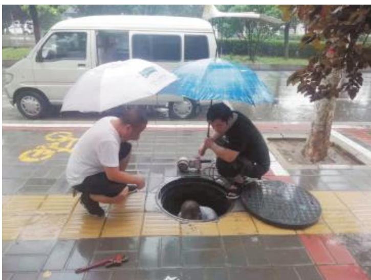
自来水公司职工在宏翔大道抢修管道
