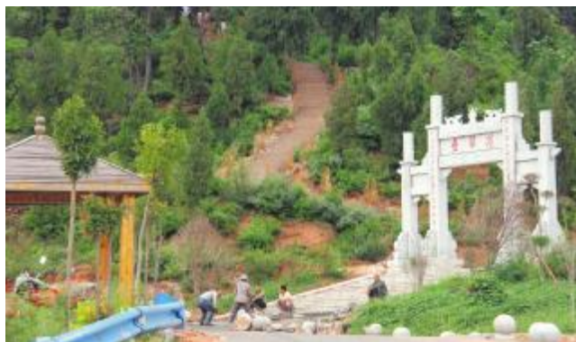
正在施工的山顶公园步道
