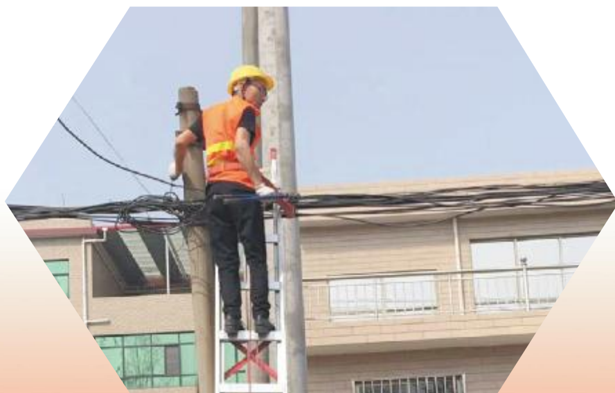
施工人员爬上电线杆
