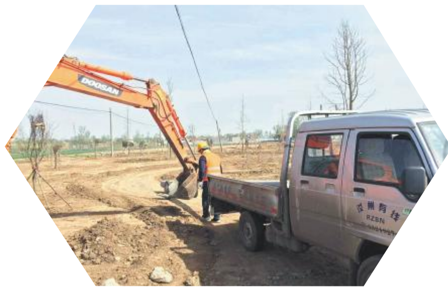
有线电视施工车在野外施工
