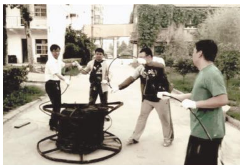
施工人员拉光纤
