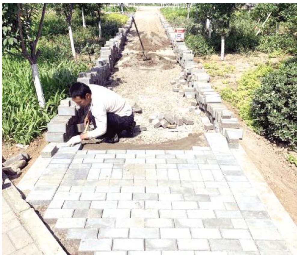
5月4日,207国道廊道绿化项目的工人们正在抢时间对土建工程施工。据了解,207国道绿化范围是人行道两侧,根据实际情况30到50米不等。因为工人修整人行道。 梁杨子 王磊 摄
