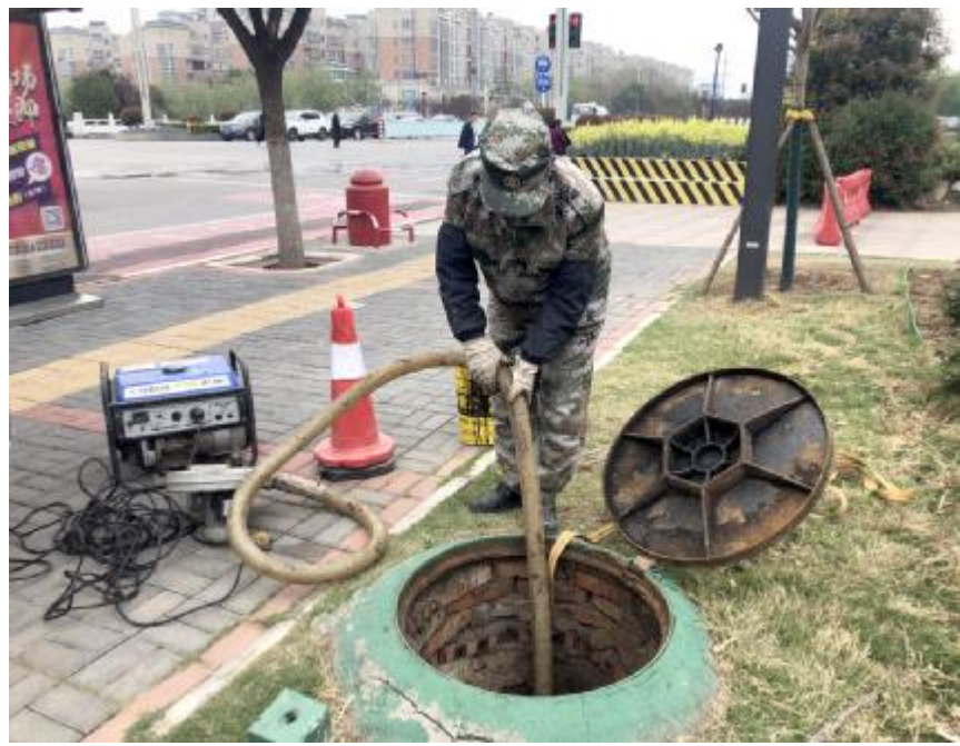
4月10日，笔者在朝阳路西段看到工人在下水道口施工，经询问是丰阳热能的工作人员在对设备进行维护保养。 牛莉萍 摄
