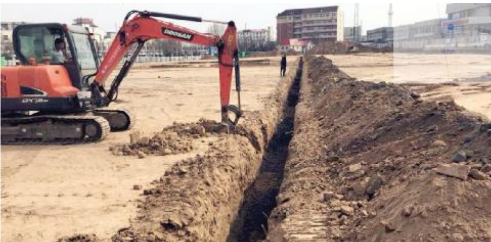
火车站广场提升改造项目现场
