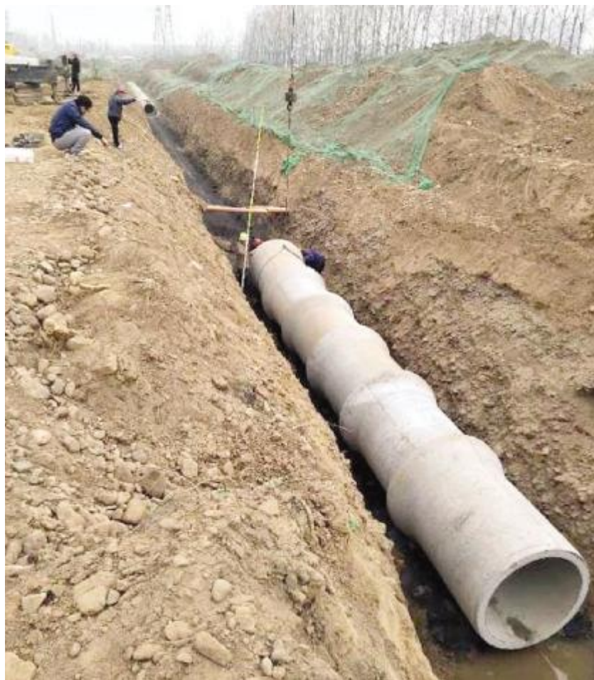
双拥路南延项目施工现场
