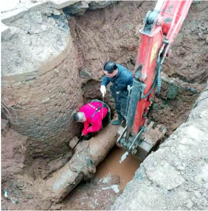
3月2日中午，云禅大道与广成路交叉口处的直径400毫米供水管道发生破裂，自来水公司维修人员冒雨在泥泞的管道坑中抢修。梁杨子 雷文娟 摄
