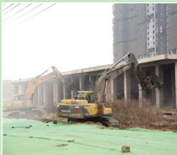
多台大型机械同时作业
