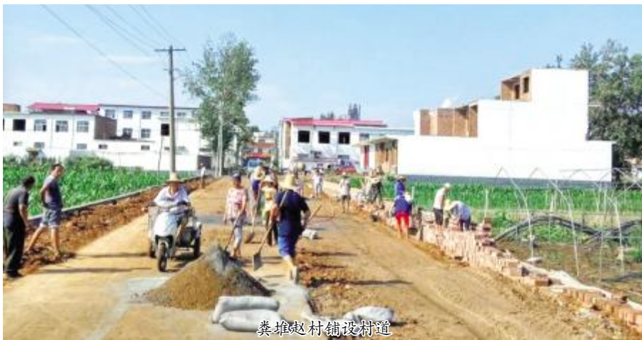
粪堆处村铺设村道
