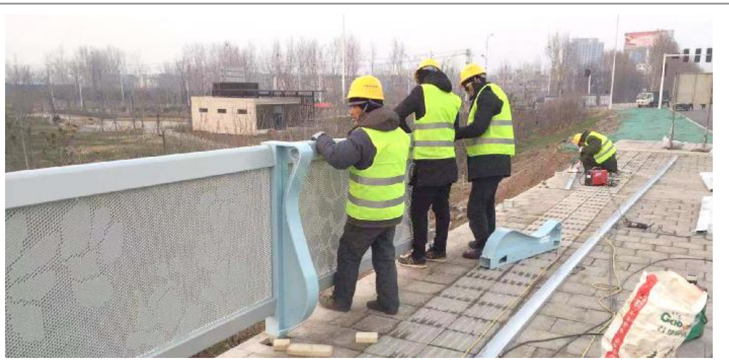
1月2日，望嵩南路汝河大桥护栏开始安装，此次安装的护栏极具汝州特色，图案花型是玉兰花，立柱是汝瓷花瓶造型，整体颜色是天青色。护栏全长1816米，大约在春节前后完成安装。 陈晶 摄
