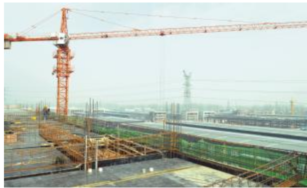
产业集聚区塔吊林立
