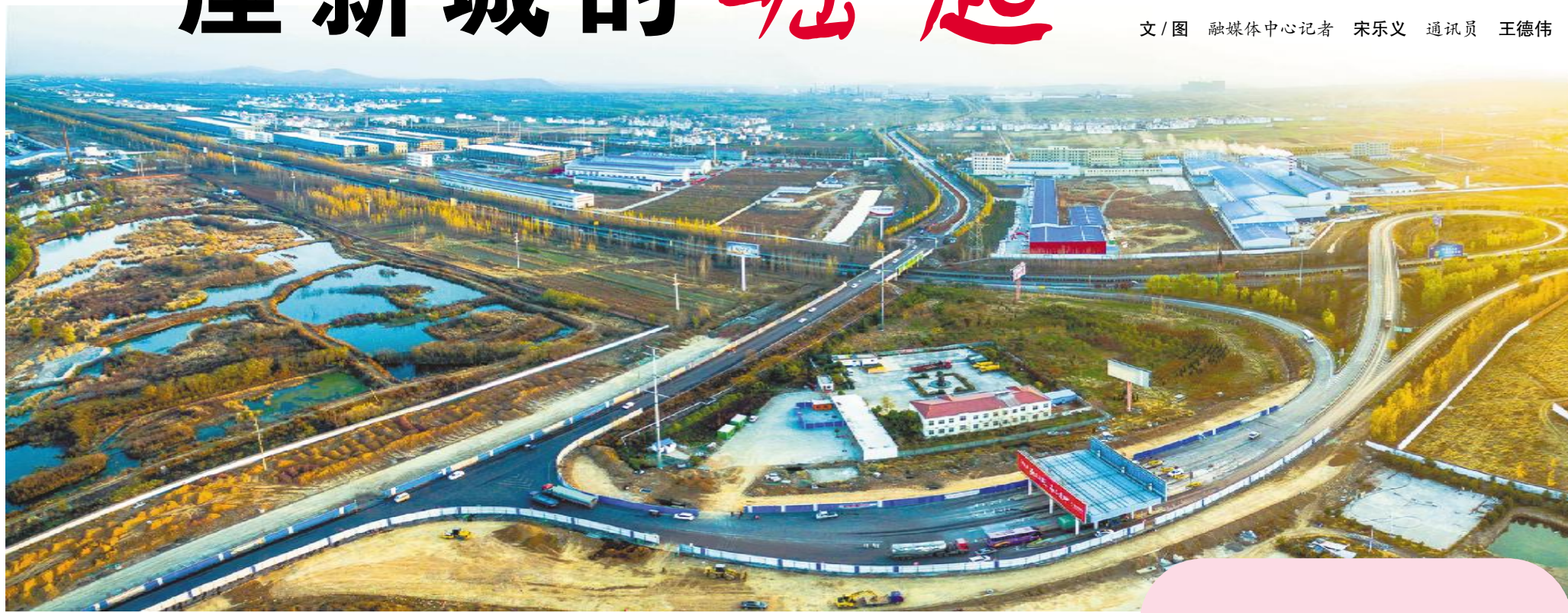
升级改造中的园区道路
