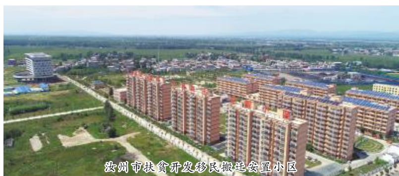
汝州市扶贫开发移民搬迁安置小区
