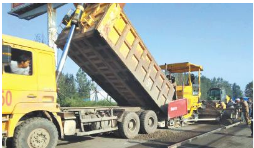
正在施工的望嵩南路
