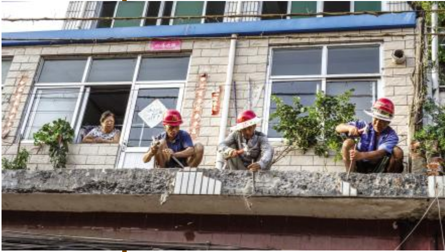
工人入户施工
