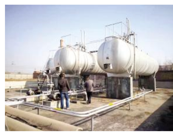
执法人员正在罐区检查
