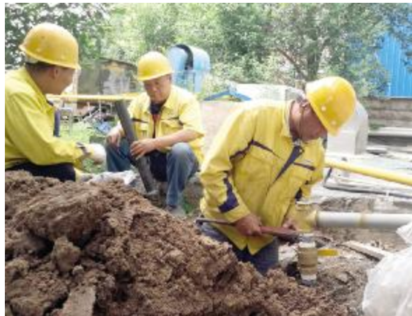
工作人员对广成学校调压柜地下铸铁管漏气进行抢修
