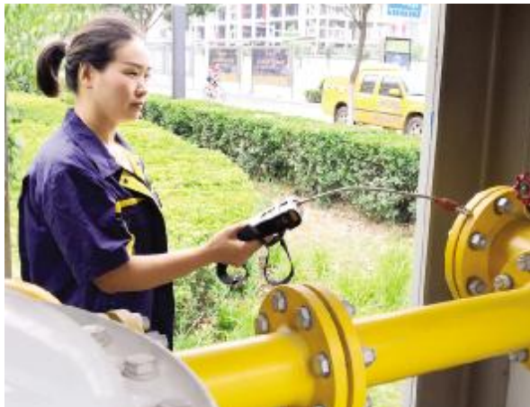
新奥燃气巡线工丁凤霞正在巡线
