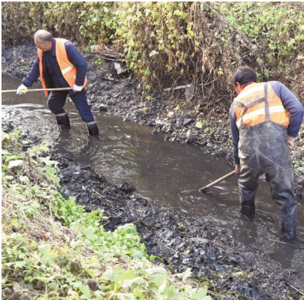
11月8日，记者在二五跃进渠城垣路至望嵩路段看到，市政人员正在清淤疏浚。
