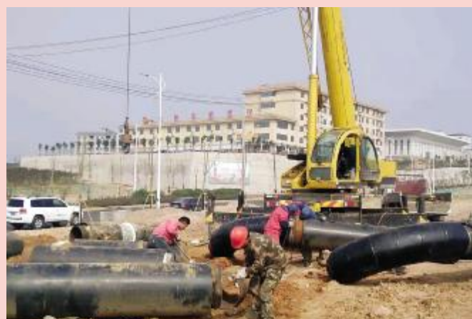
科教园区供热施工现场
