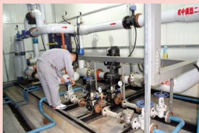
工作人员检修换热站设备
