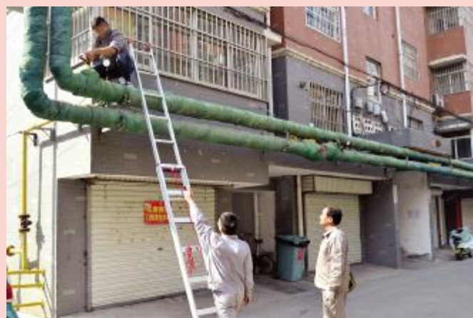
工作人员检修社区供热管网
