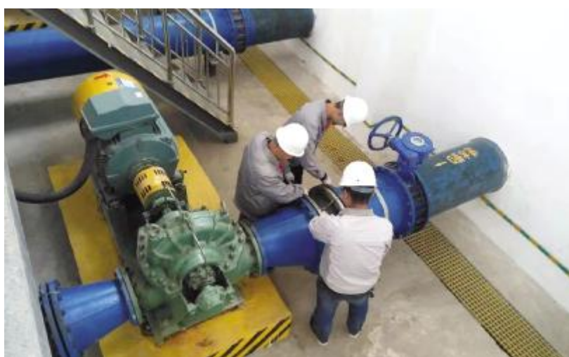
第三水厂工人检修设备
