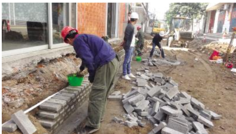
北门里街改造提升施工现场
