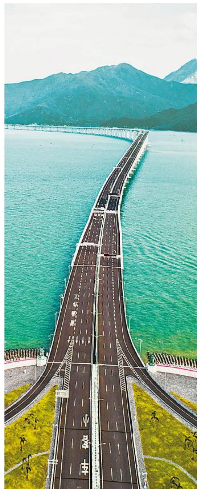
港珠澳大桥香港段由东端的香港口岸人工岛和向西连接大桥主体的12公里香港接线组成,是这一超级跨海通道的重要组成部分。图为港珠澳大桥香港段(10月13日摄)。
