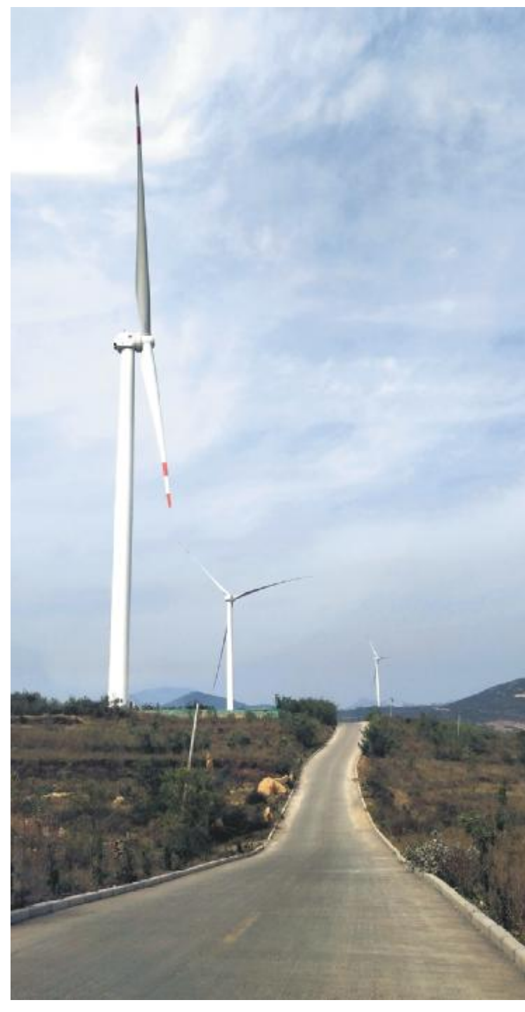
日前，记者在大峪镇魏马线东部沿线发现，由中广核集团建设的风电项目正在施工，部分发电设施已经安装到位，成为山乡一道新风景。
