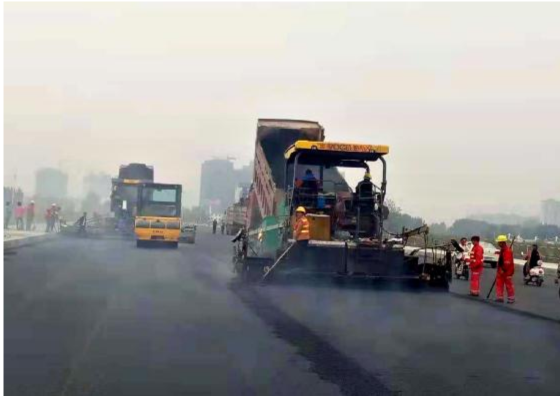
10月15日，记者在望嵩南路汝河大桥施工现场看到一片繁忙的景象，该段沥青路面正在加快施工。据了解，该路段将于本月25日开始通行。 宋乐义 王德伟 摄
