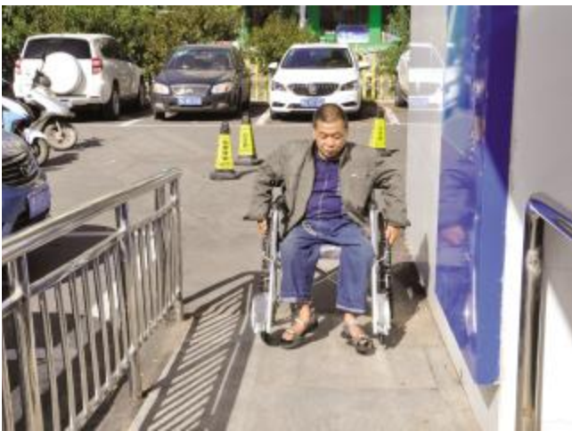
建设银行门口的无障碍通道宽敞、平缓,体验者可自行上下
