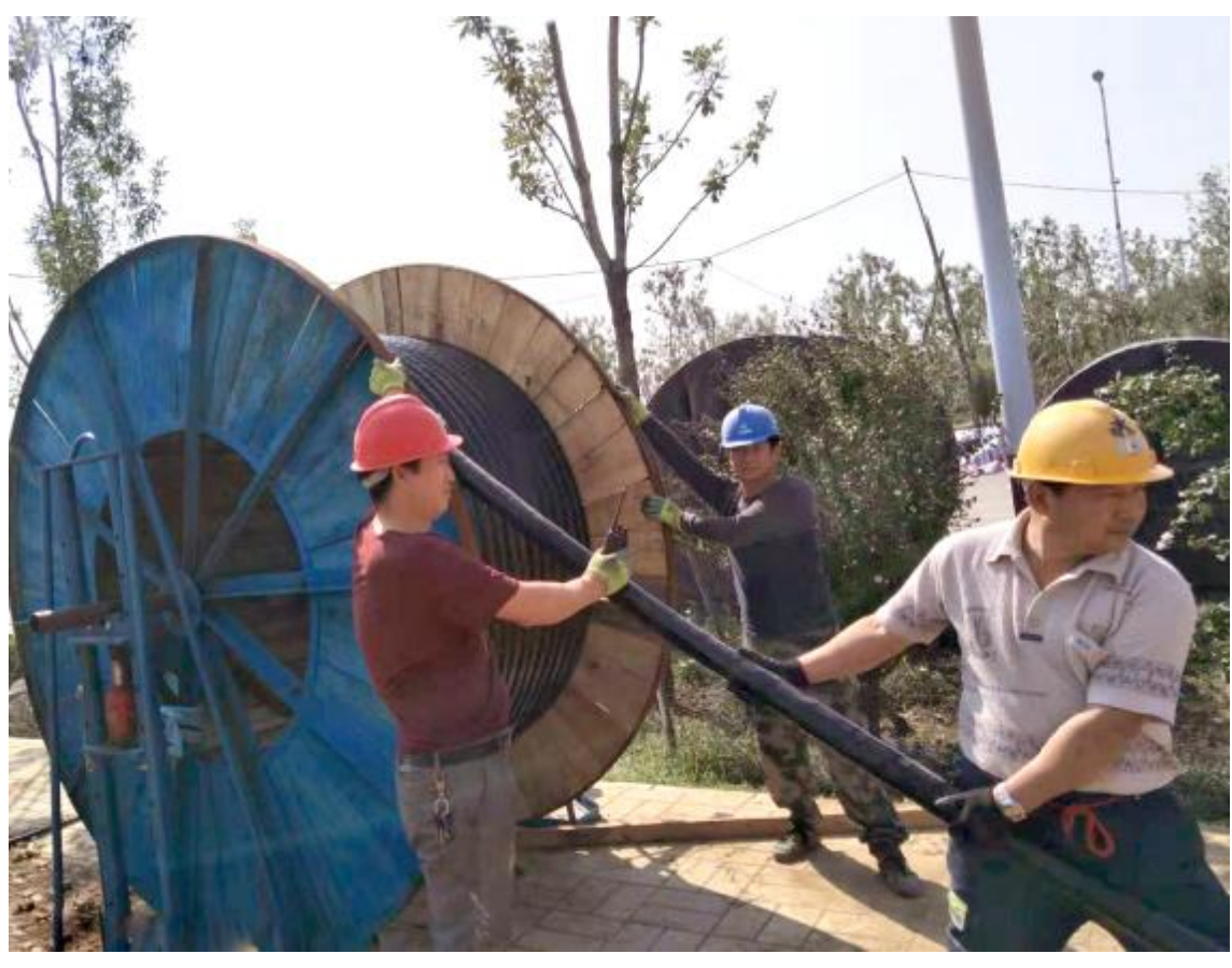
10月7日,两园一路项目滨河公园新203水系箱涵建设、亲水平台建设、园路沥青铺装施工现场如火如荼,建设项目正在加紧推进。图为建筑工人在两园一路施工现场穿高压线。
