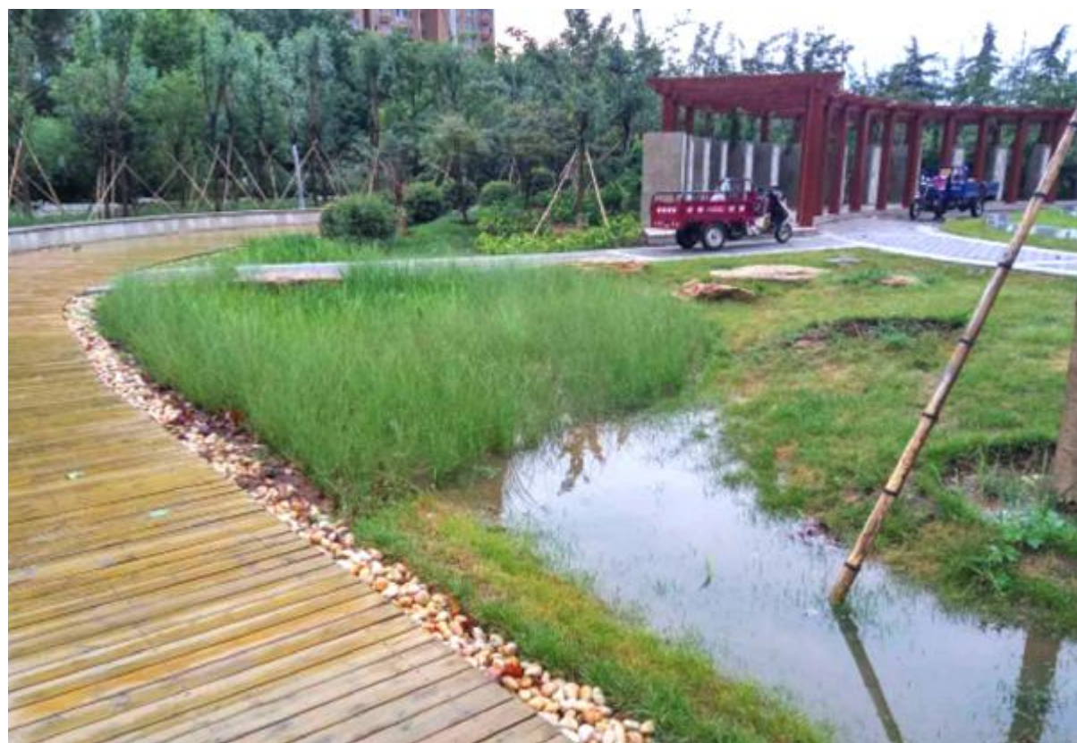
和园(公路局游园)又称雨水花园，通过浅凹绿地用于汇聚并吸收地面的雨水，利用植物、沙土的综合作用使雨水得到净化，涵养地下水。
