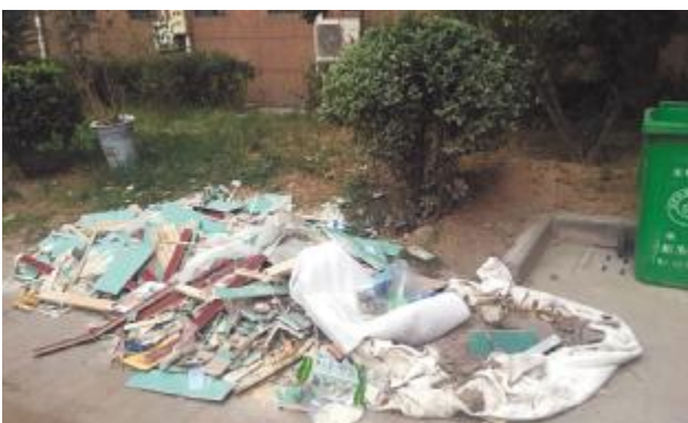
福地国际花园小区建筑垃圾随意堆放
