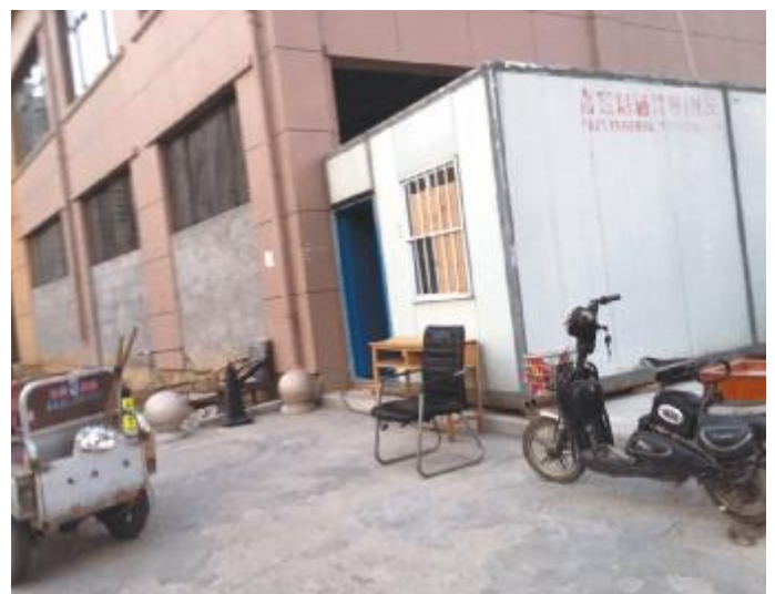
怡景苑小区保安室为临时搭建建筑,且周边环境差
