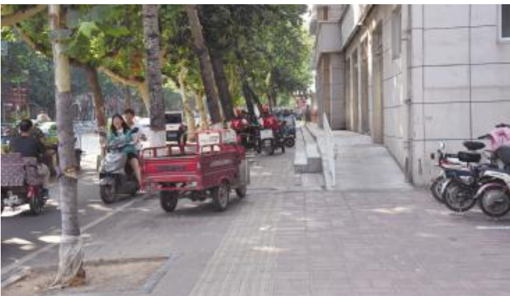
丹阳路市政府东部分路段盲道被占道。 陈晶 摄
