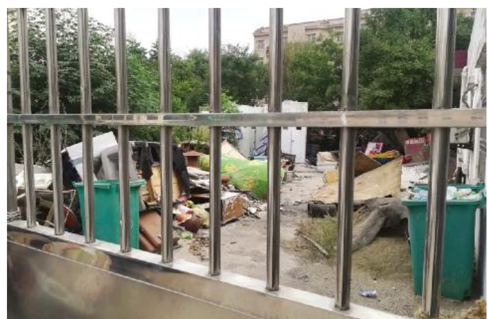
梨园新区水泵房小院里堆满了杂物,无人管理。
