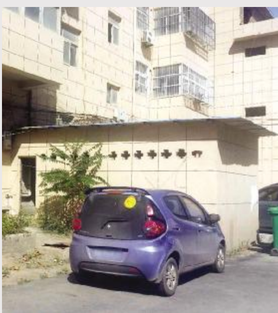
大众巷无名小区沿街修建水泵房,车辆停在路边。
