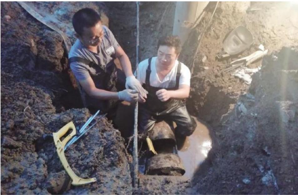
8月22日下午,望嵩路DN300供水管道爆裂,市自来水公司维修队员跳入泥潭中全力抢修漏点,于晚上9点30分,破损管道修复完成,恢复供水。
