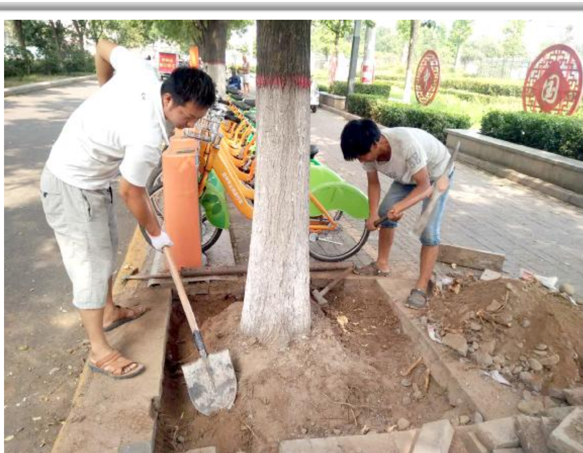
8月14日，市住房保障管理中心组织施工队对朝阳路分包路段破损树木进行维护。
