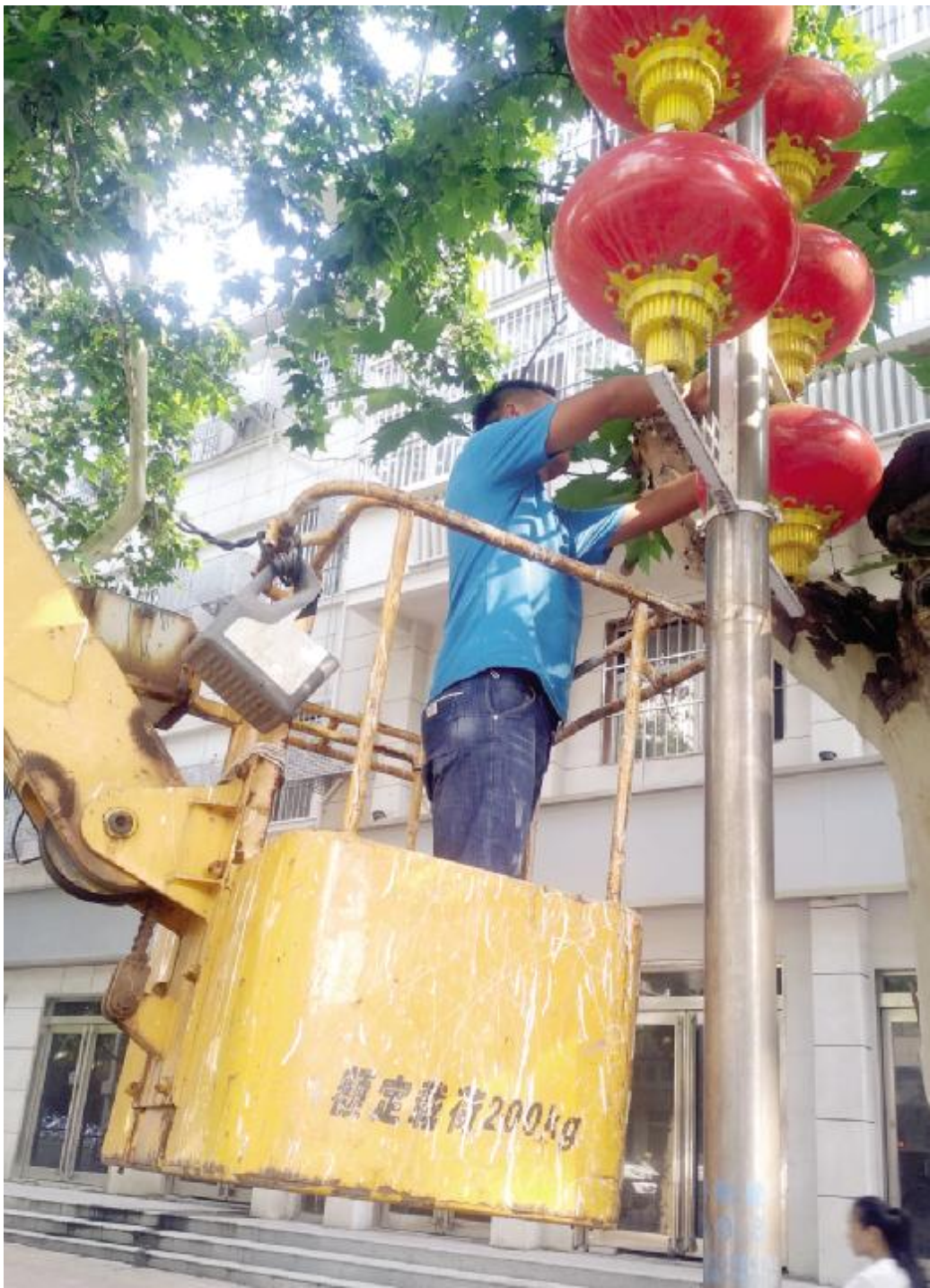
8月13日, 路灯管理所维修人员对市区路灯及灯饰进行检查维修, 助力创文工作。 梁杨子 耿晓磊 摄
